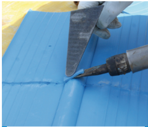
e) aplique una tira de PVC sobre el bulbo para reforzarlo
