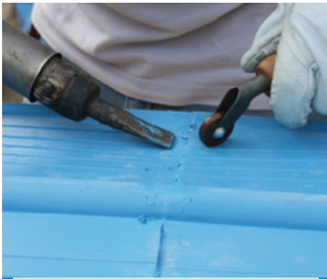
d) paso final del procedimiento de soldadura
